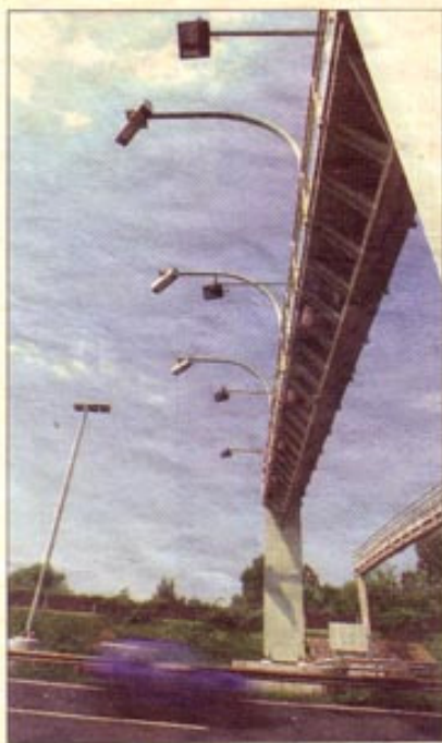
Binnen sechs Monaten wären die Lkw-Mautbalken Pkw-tauglich umgerüstet.
